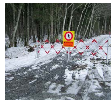
Fig. 24 Chiusura con una griglia allungabile a forbice
